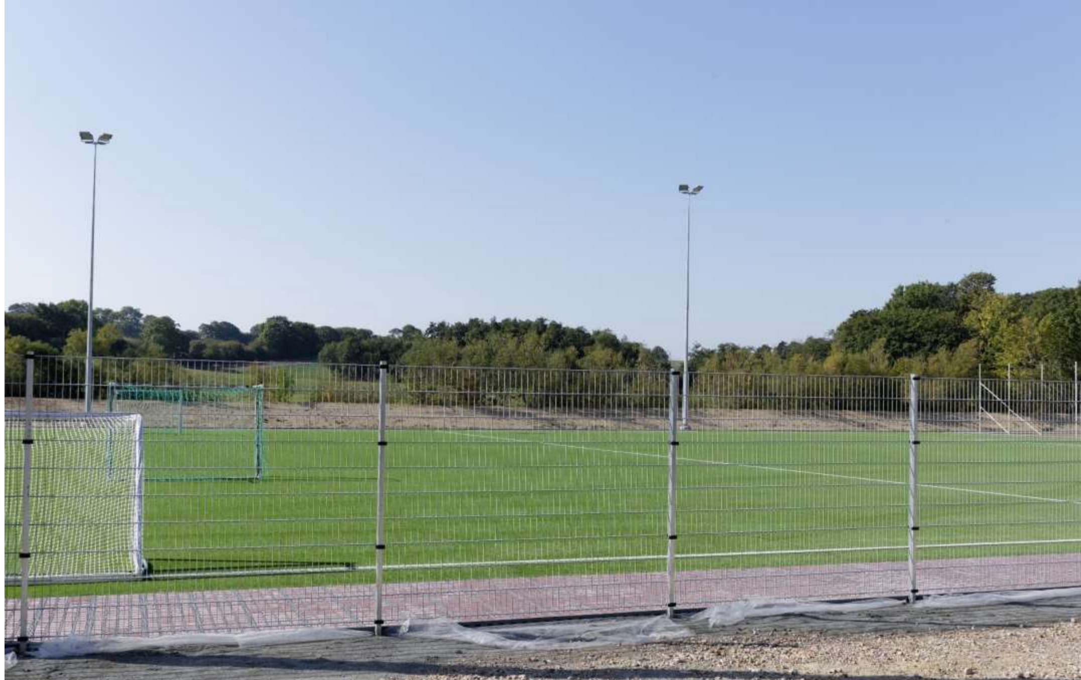
Punkt 4 – eksisterende forhold – set fra Kultur- og Idrætscentret i Fynshav nordøst for højspændingsstationens placering
