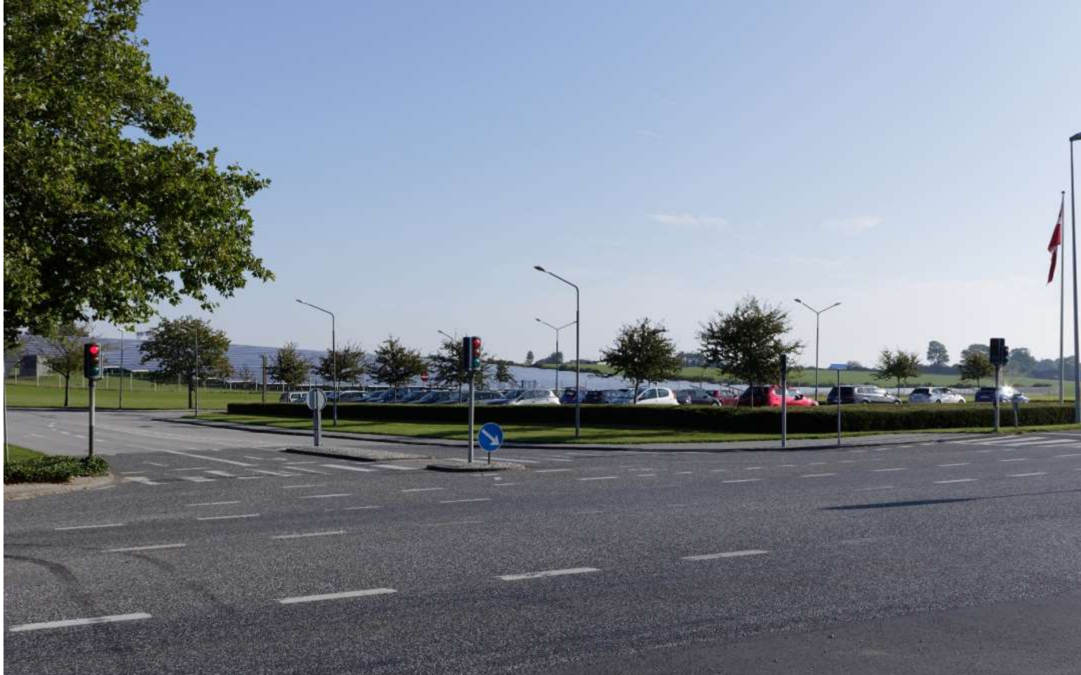
Punkt 2 – eksisterende forhold – set fra Lundenvvej sydvest for højspændingsstationens placering
